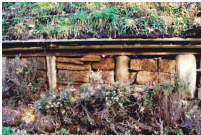
Die ganze Hütte besteht fast ausschließlich aus Naturprodukte, wie beispielsweise Weißtorfsoden, Holz, Reeth und Heideplaggen. Lediglich die Scheiben in den Fenstern waren aus Glas. Gar nicht so selten wurden Fenster eingebaut, für die es auf der Geest oder Marsch keine Verwendung mehr gab.
