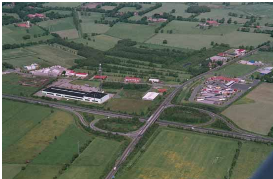
Das Industriegebiet an der Autobahnabfahrt Apen/Remels.
