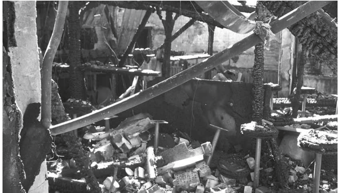
Ein Bild des Grauens: Blick in die Disco aus Sicht des Kassenvorraums. Sogar Deckenträger aus Stahl schmolzen wie Butter bei der Hitze. Foto: de Buhr
