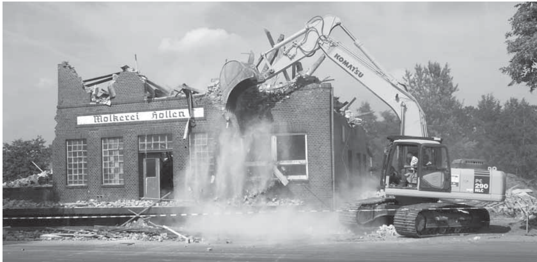
Die gefährlichsten Arbeiten waren die kurz vorm Schluss. Die markante Frontseite mit dem Schriftzug grenzt unmittelbar an die Straße. Zahlreiche Schaulustige waren täglich vor Ort.
