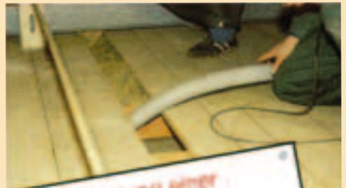
Dämmung einer Holzbalkendecke
