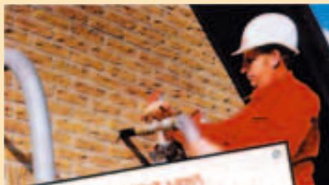
Dämmung von zweischaligen Mauerwerk
