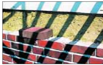
Hohlchicht mit Rockwool-Wärmedämmung.
