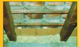
Dachschräge (mit Hinterlüftung)
