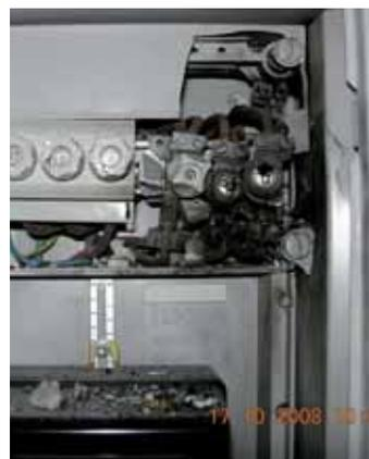
Links: der Zählerkasten im Flur. Die Hauptleitungen sind völlig verschmort und mussten durch Elektriker wieder neu angeschlossen werden. Rechts: die Dusche wenn. Wer zum Zeitpunkt des Blitzeinschlages gebadet oder geduscht hätte, wäre sicher nicht mehr am Leben.
