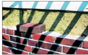
Hohlschicht mit Rockwool-Wärmedämmung.
